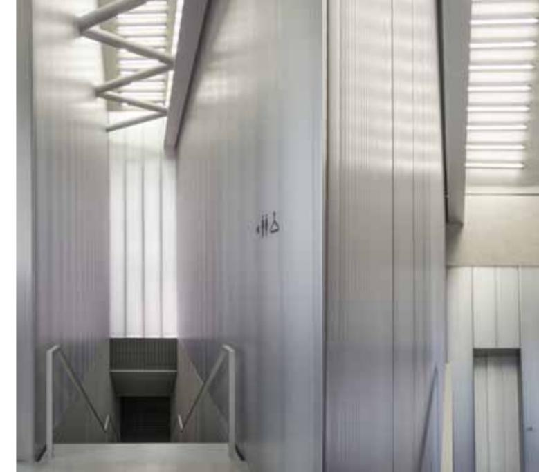
Ogni singolo pannello è stato prodotto su misura e lavorato per garantire linee precise nel loro accostamento con le superfici irregolari dell'edificio pre-esistente. Come la realizzazione direttamente in- loco di angoli e spigoli ha permesso di ottenere superfici senza soluzioni di continuità.
